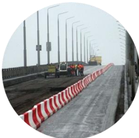
Ремонт мостов в качестве материала для закупорки стыков
